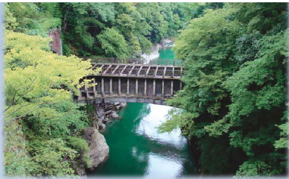
ハツ沢発電所第一号水路橋(国重要文化財) 大月市猿橋より撮影(写真提供:東京電力大月支社)
