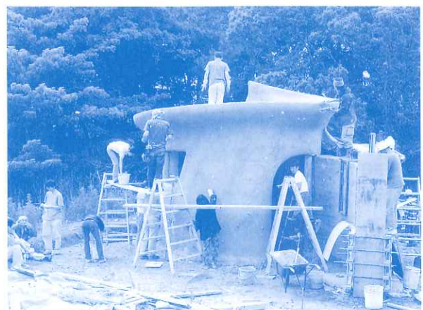
学生と自然建築愛好家でのワークショップによるストローベイル建築づくり
