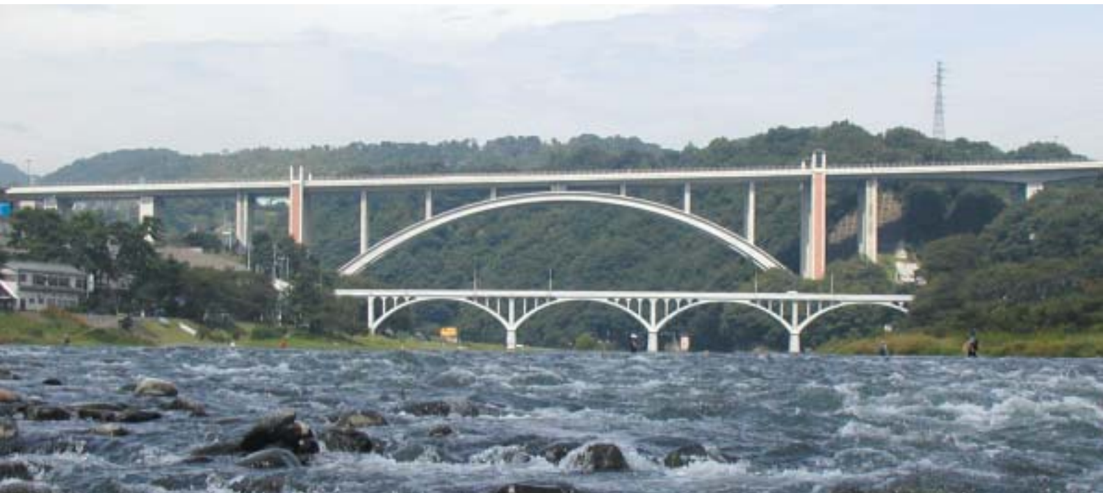
上の橋:2004年3月6日に開通した新小倉橋 下の橋:これまでの小倉橋 (写真提供:神奈川県津久井土木事務所)
