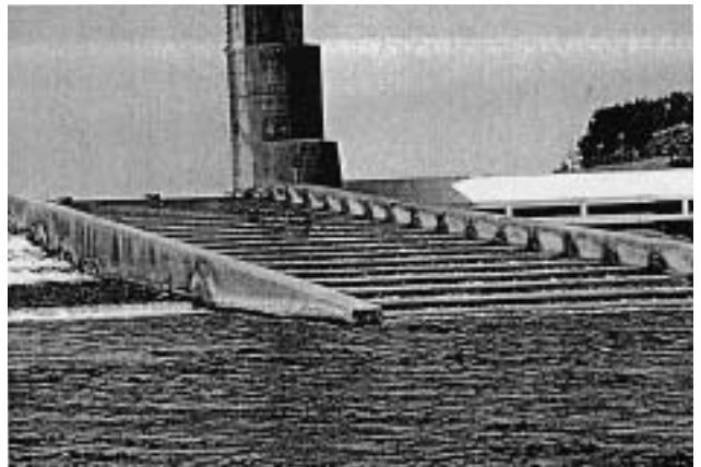
寒川取水堰・階段式魚道
