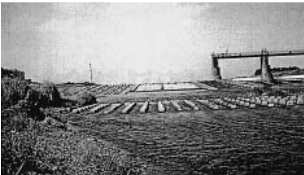
寒川取水堰・魚道
