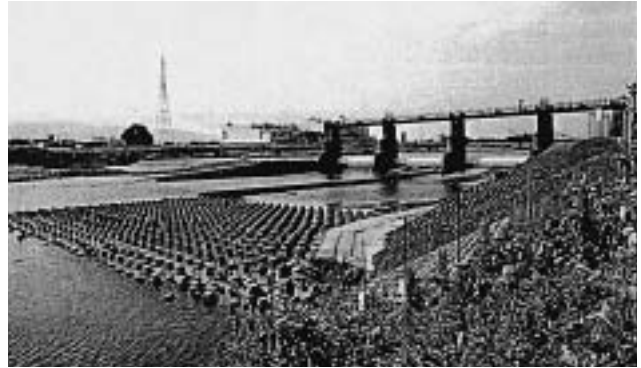
寒川取水堰・全景
