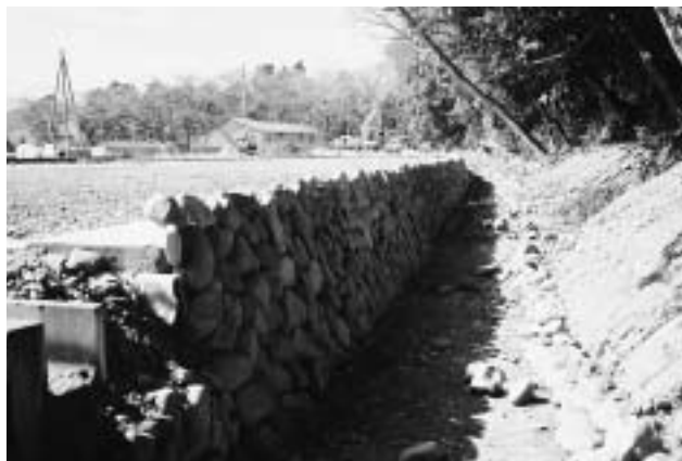
湧水が溜まらなくなった用水路改修工事
