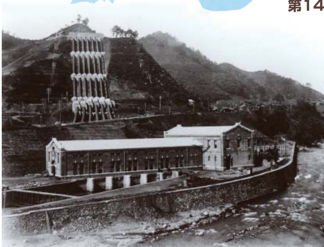
創設当時の駒橋発電所 (写真提供:東京電力(株)山梨支店大月支社)
