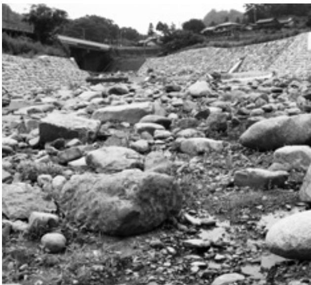
奥は国道20号及びJR中央線 周辺環境に溶け込んだ自然石護岸
