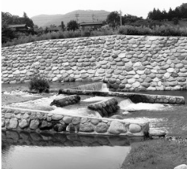
ヤマメ、アユなどの小型魚を対象に巨石を使用した魚道 留意したこと
