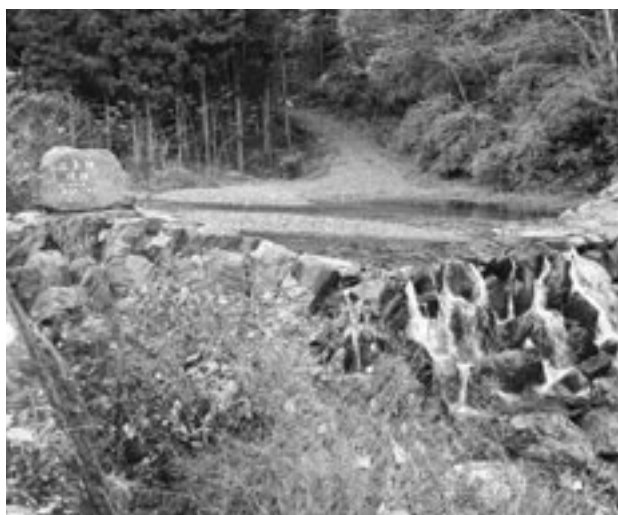
「石丸積工法」による砂防ダム
