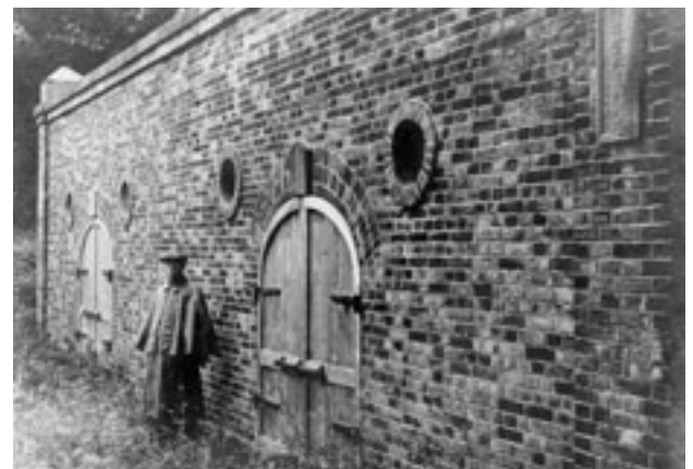
走水覚栄寺裏山貯水池(明治41年完成)
