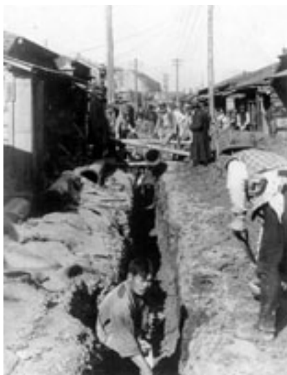
配水管布設：逸見地区(大正10年頃)
