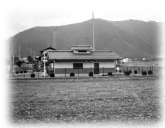
大型排水処理施設と点在する集落
