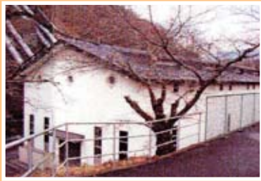
ハツ沢発電所
