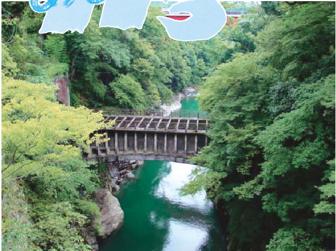
ハツ沢発電所第1号水路橋(国重要文化財)
