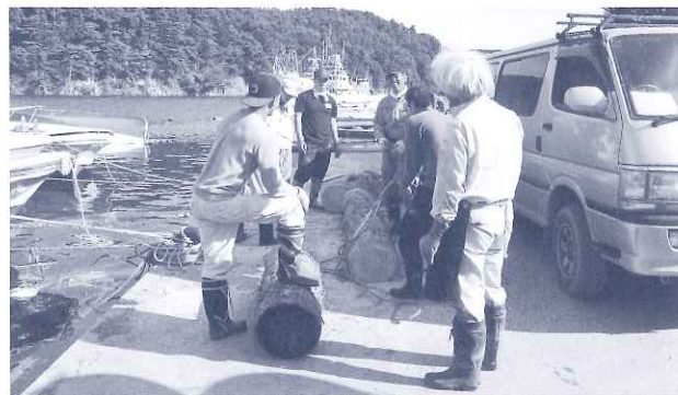
漁港の整備作業の様子(2011.6)
