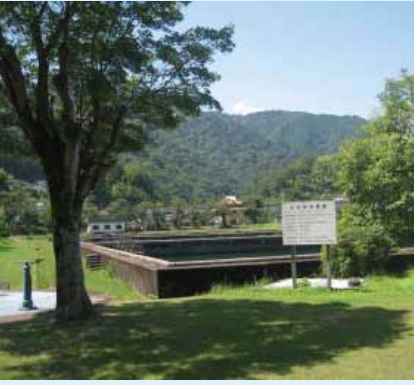
横須賀市上下水道局半原水源池
