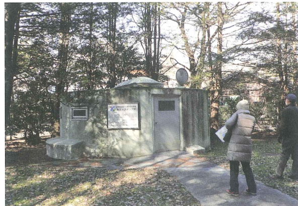
栗原水源ポンプ所
