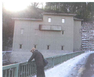
川合ポンプ場
