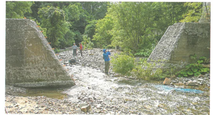
逆台形型にスリット化した治山ダム
