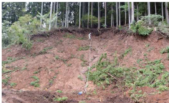
道志村下善之木被災状況
