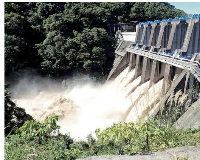
台風後の放流の様子（城山ダム）
