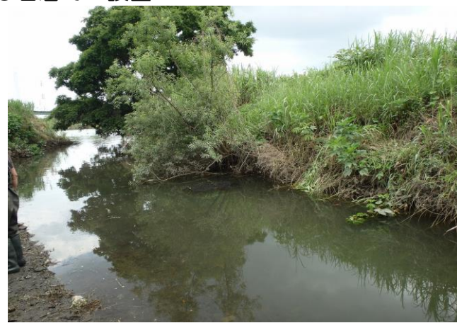
○石倉カゴ設置
