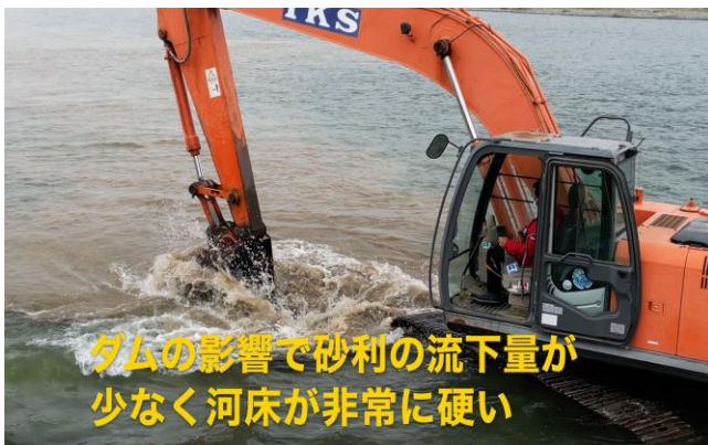
(重機での作業)
