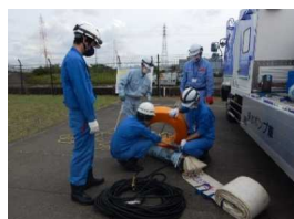
ポンプの組立
