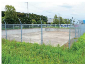
地表面貯留施設
