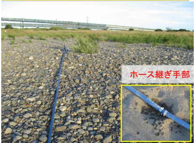
100m以上のホースで水が圃場に向かいます。一部ホースの継手は水漏れ対策が必要。
