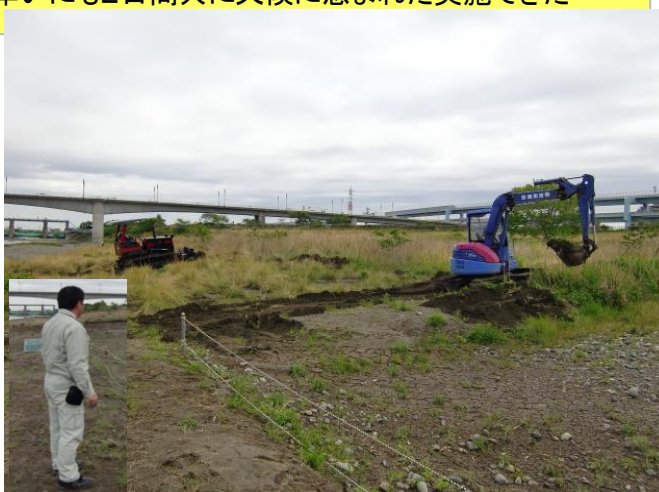
河川の環境保全のため、河原に堆積した土砂の除去実施、重機:ユンボ(2台)土砂運搬(1台) '11年、'12年は雨の中で実施したが、今回は幸いにも2日間共に天候に恵まれた実施できた
