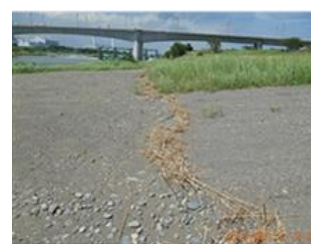
増水時の最高水位ライン
