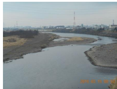
2015年3月15日 河道整備工事の進捗状況
