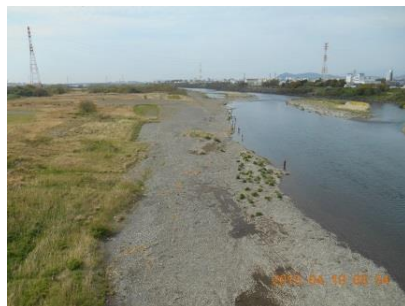
2015年4月19日 完了した河道整備工事
