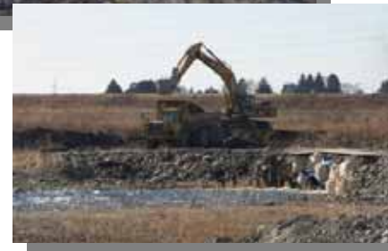
重機による表土の剥ぎ取り（上）とれき河原の再生工事（右）
