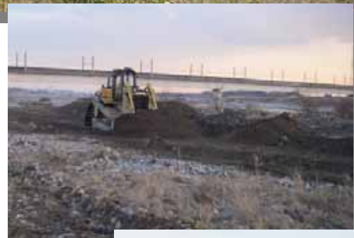
重機による表土の剥ぎ取り（上）とれき河原の再生工事（右）
