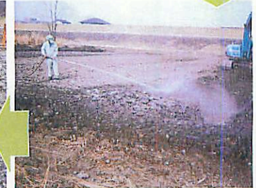
放水により細粒土砂を除去
