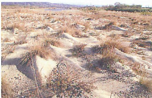
株の根元に土砂が溜まっているようす(木津川, 2004.12.23)
