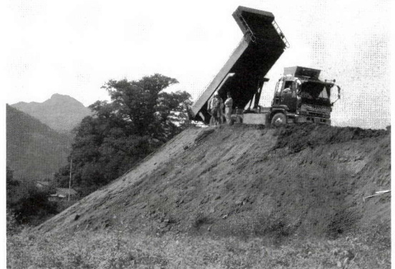
上流域の残土処分
